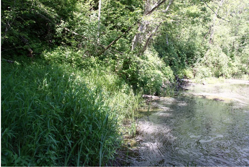
Foto 4 – Tugevasti taimestunud varikalle Essi müüri jalamil ulatub veeni (foto: T. Meidla, 2017).
